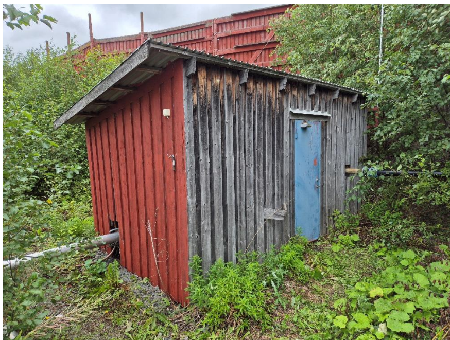
Figur 8-3 Pumpstationen för vattenuttaget vid Hissmofors.
