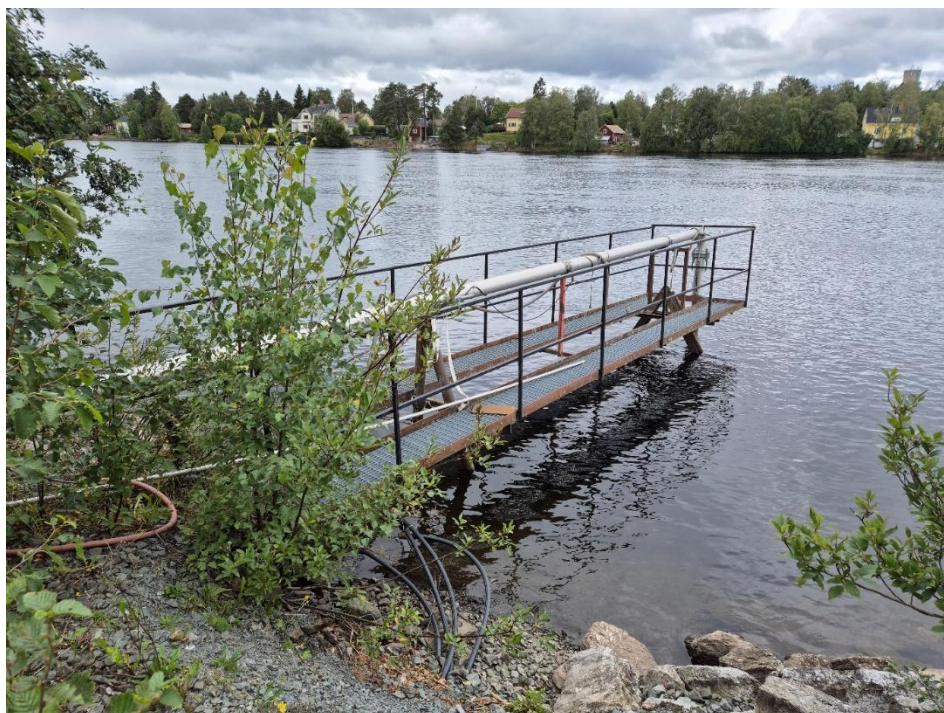
Figur 8-2 Anläggningen för vattenuttag i Indalsälven.
