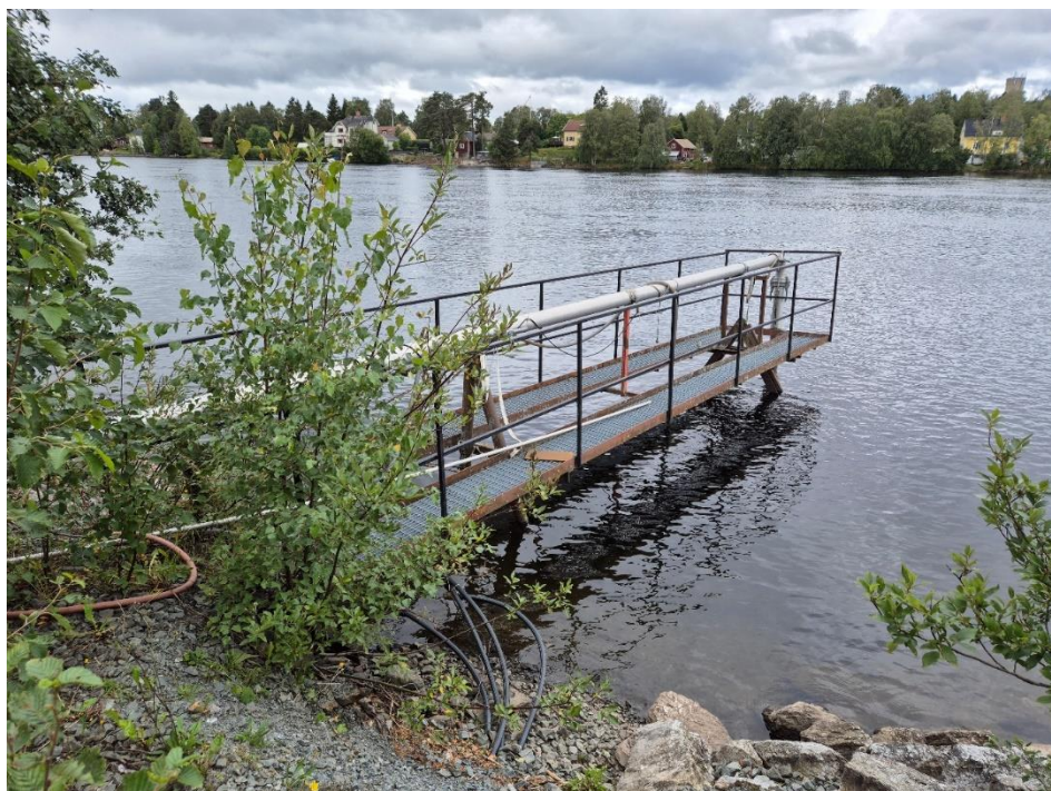
Figur 8-2 Anläggningen för vattenuttag i Indalsälven.
