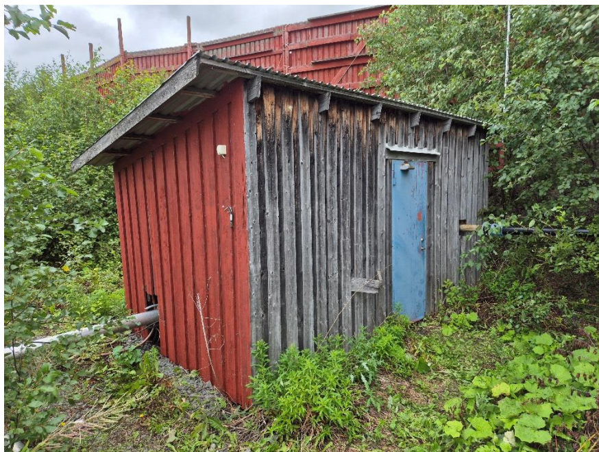
Figur 8-3 Pumpstationen för vattenuttaget vid Hissmofors.
